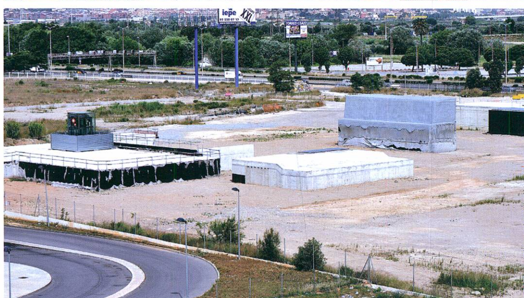
Aspecto actual de las obras de la parada de metro en plaza de Catalunya y de la estación intermodal, junto a la actual de Rodalies
