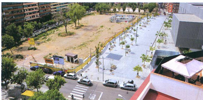
Obras de la parada de metro a plaça de Catalunya.
