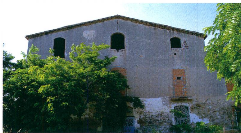
Les espitlleres a la façana de Cal Monés serveixen per combatre els atacs dels pirates.
