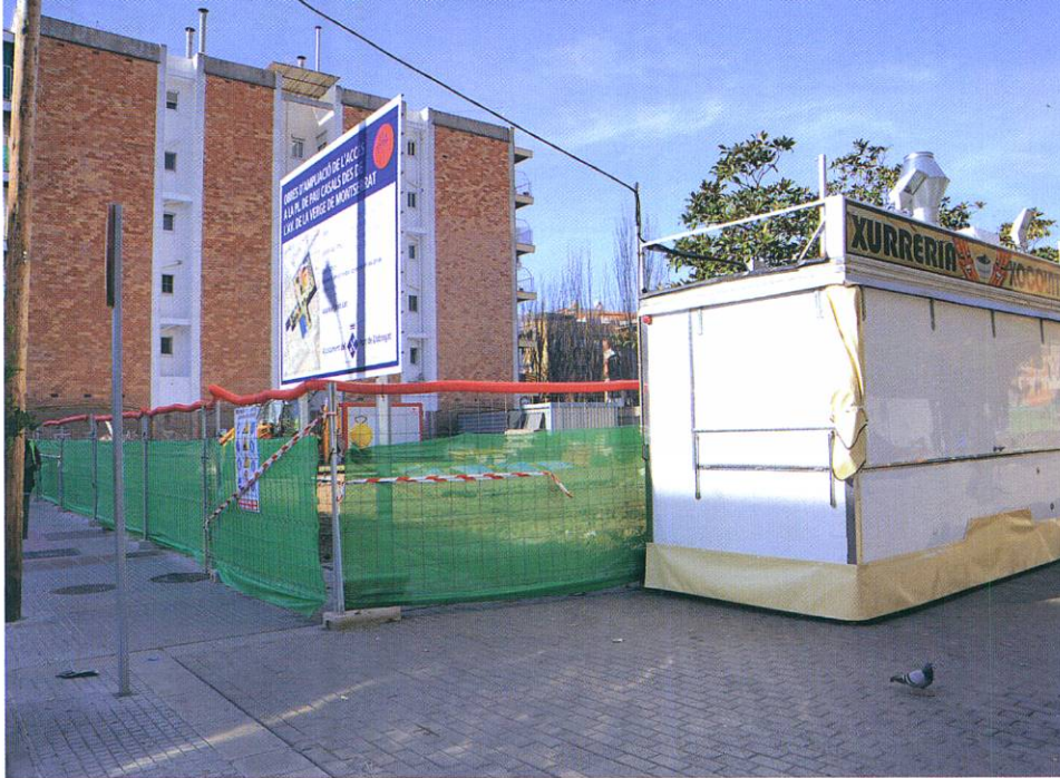
Ja s'ha eliminat la tanca de formigó que separava el solar de la plaça
