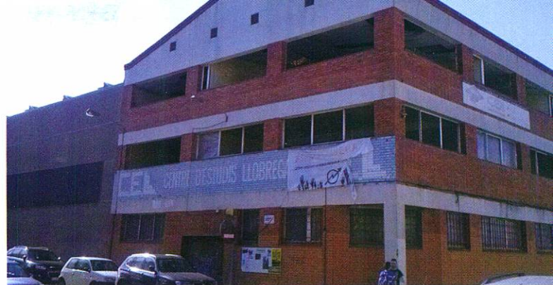
Edifici de l'antic CELL on s'hi han instal·lat els ocupes
