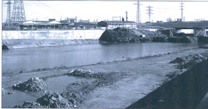
L'estat actual de les obres al riu
