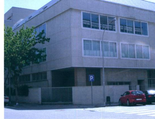
El pla contempla la remodelació de l'edifici del carrer Lo Gaiter per convertir-lo en el centre cívic del barri
