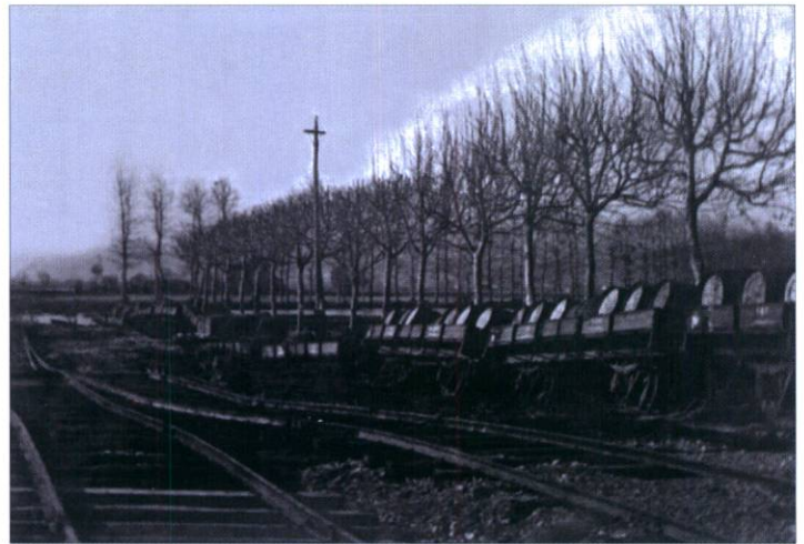
Vista de les vies ferroviàries de la zona del "pont de les tres puntes". Arxiu: Pedro Garcia Vela
