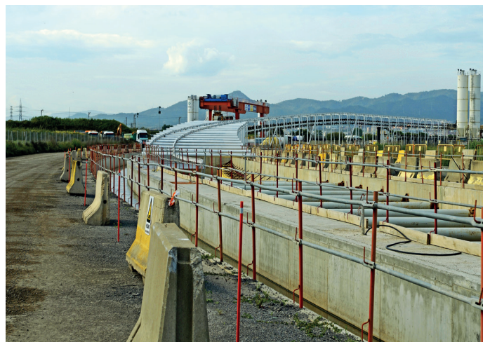
Obres del nou ramal ferroviari, al parc Agrari, entre els termes del Prat i Sant Boi | FOTO: QUIM TORRENT
