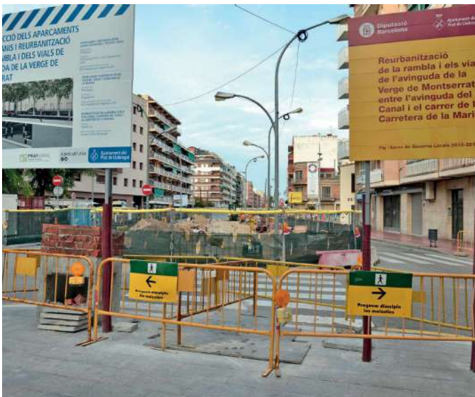
Obres de la nova rotonda. FOTO: Q. TORRENT
