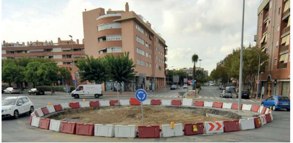
Obres de la nova rotonda. FOTO: Q. TORRENT
