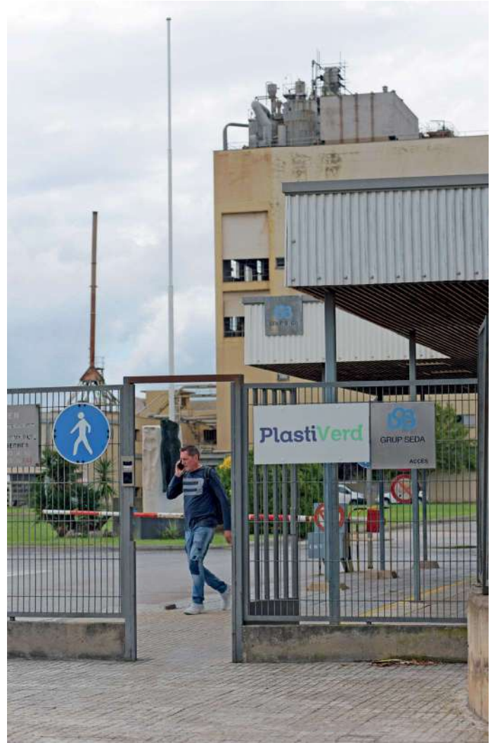
Planta de Plastiverd al Prat FOTO: Q. TORRENT
