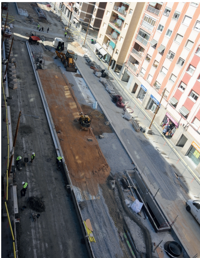
Vista aèria de les obres de Verge de Montserrat | F. Serrano
