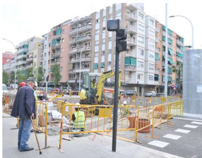
Obres de reparació d'un col·lector a l'avinguda | F. SERRANO
