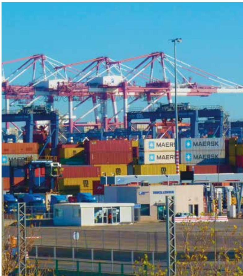
Grues de la terminal BEST del port / Foto: ARXIU DELTA
