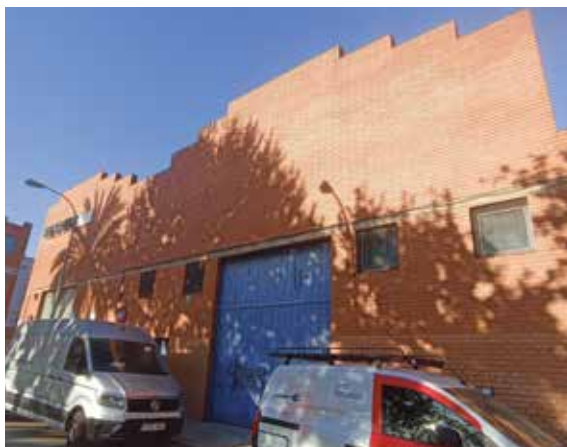
Façana del nou local que serà destinat a centre religiós islàmic
