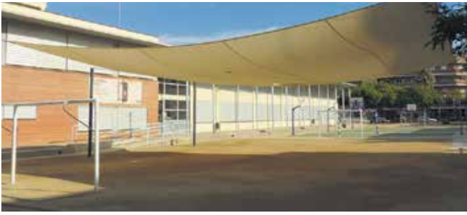
Vela instal·lada a l'escola Bernat Metge / Foto: ARXIU DELTA
