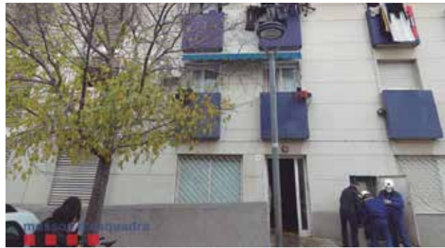
A l'esquerra, interior d'una de les habitacions amb plantacions de marihuana. A la dreta, façana d'un dels edificis intervinguts / Foto: PREMSA MOSSOS
