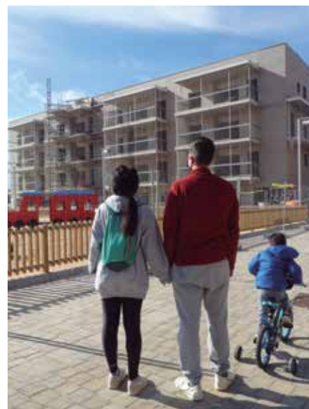
Habitatges en construcció a l'ARE Sud del Prat / ARXIU
