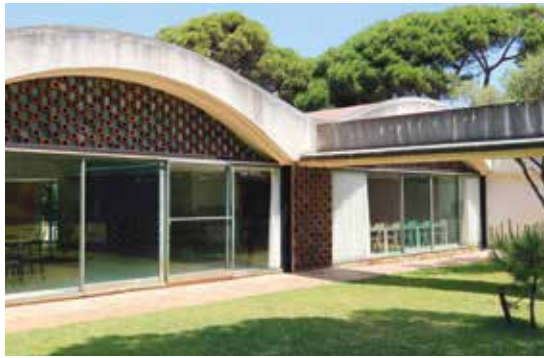
Detall de la façana de la Casa Gomis / ARXIU DELTA
